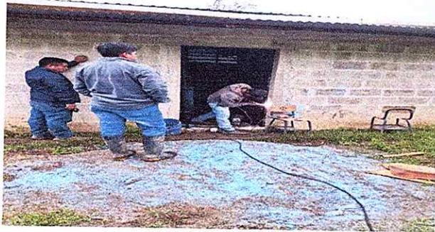
Foto 5: PROCESO DE INSTALACION DE UNA PUERTA DE METAL CON LAS MEDIDAS 1.92M X 0.93
